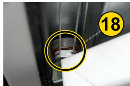
Ce dispositif stoppe le mouvement du tablier en cas de rupture de l'un des câbles reliant le tablier au système d'équilibrage.
