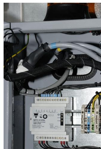
Raccorder le câble (2) d'alimentation secteur sur le bornier de l'armoire (1).
