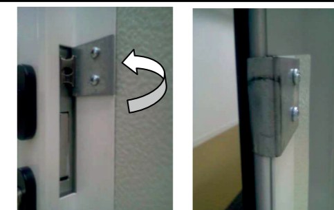
mise en place de la cale portillon située au niveau du verrouillage
