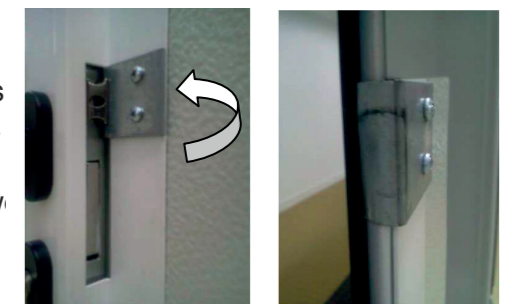
Aufstellung des Schlupftürkeils, die auf dem Niveau der
