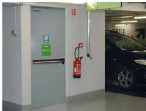
En 30, 60 et 120 minutes EI (selon norme EN), en 1 ou 2 vantaux, et grâce à ses différentes caractéristiques, la gamme F-Max répond à tous types de bâtiments et d'usages.
