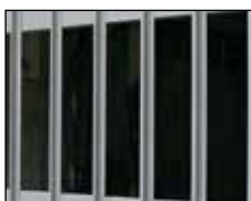
Barreaudage en T
