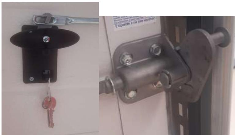
3. Verrouiller votre serrure à l'aide du verrouillage intérieur, votre poignée ne peut plus être manœuvrée et votre verrouillage restera en position porte motorisée.
