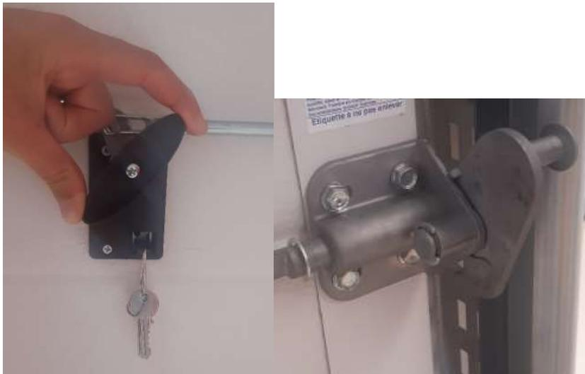
Remettre la poignée en position horizontale afin de bloquer la pièce rotative dans sa position.
